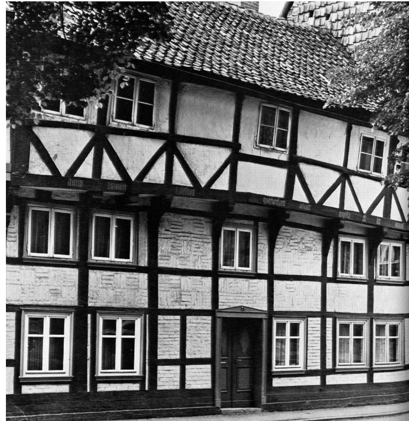
Haus mit teilweise ausgemauertem Gefache
